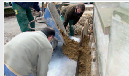
9 Abdichtung der Fundamente
