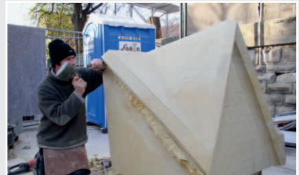
7 Bearbeitung des Verdachungssteins
